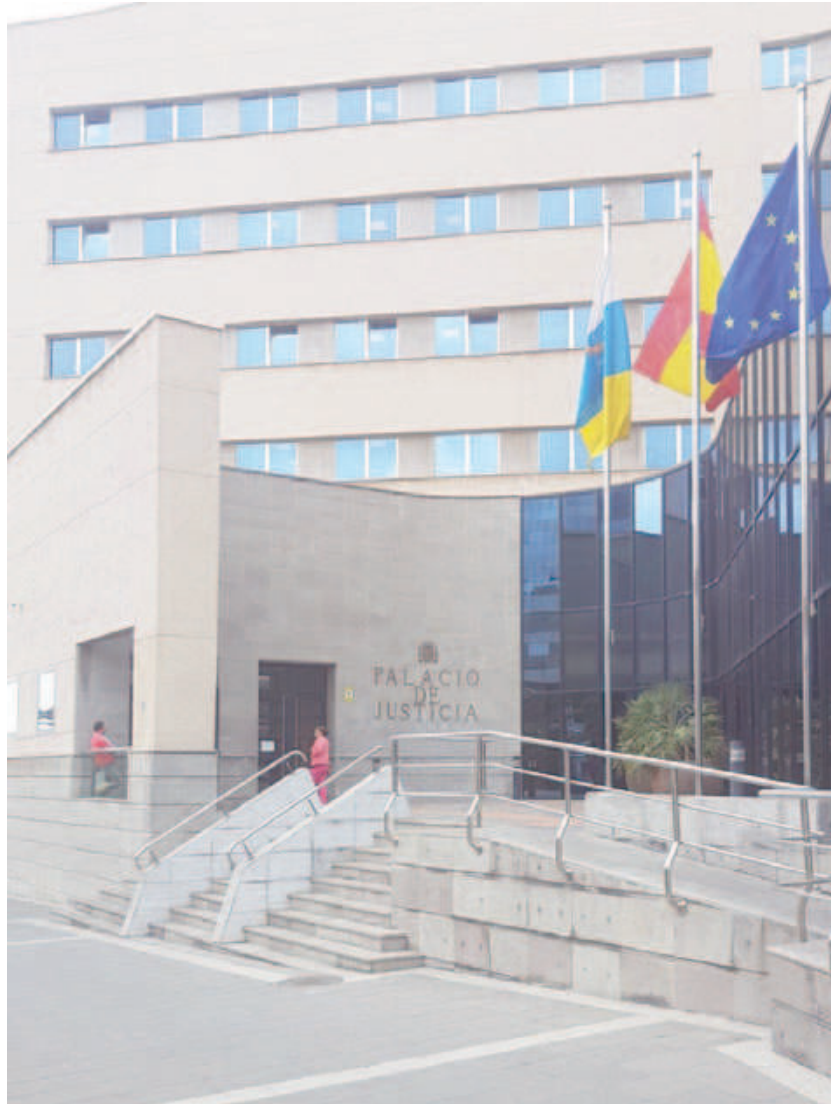
Fachada del actual Palacio de Justicia, en la Avenida Tres de Mayo. | LOT
